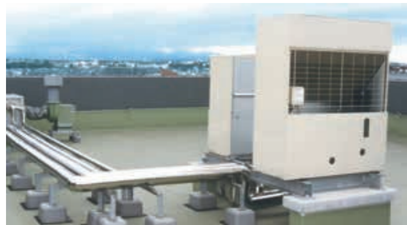
●屋外機とラッキング冷媒配管
